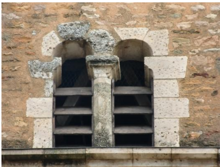
vue d'ensemble côté sud et baies géminées du clocher
