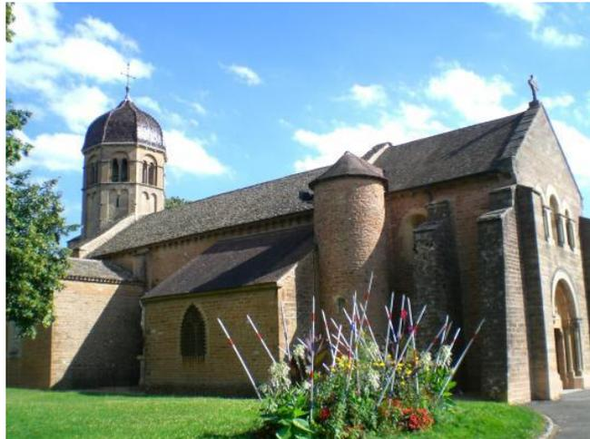
*Un exemple unique en Bourgogne : la voûte de la nef en berceau légèrement brisé supporte le toit de laves sans aucune charpente*
